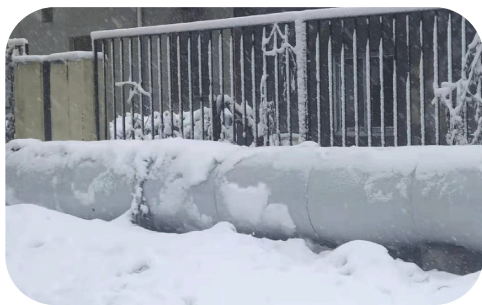
图 9 保温改造后的蒸汽管道
