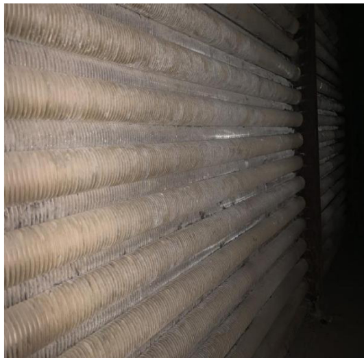
图3 排管翅片密集积灰
